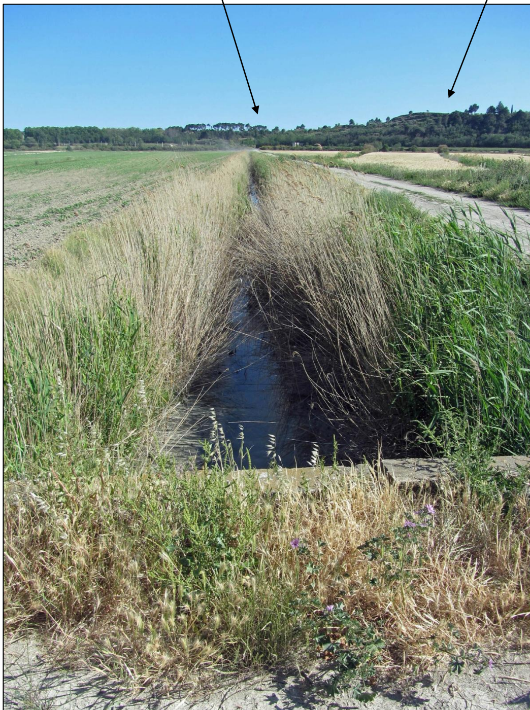
La canal d'évacuation des eaux du périmètre en direction du sud vers le Malpas
