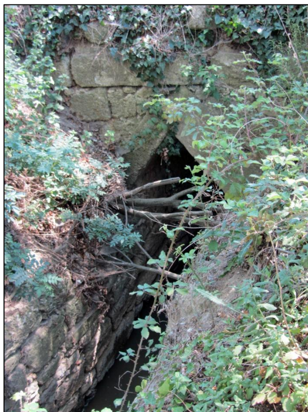
Réenfouissement du canal d'évacuation des eaux du périmètre après le Malpas
