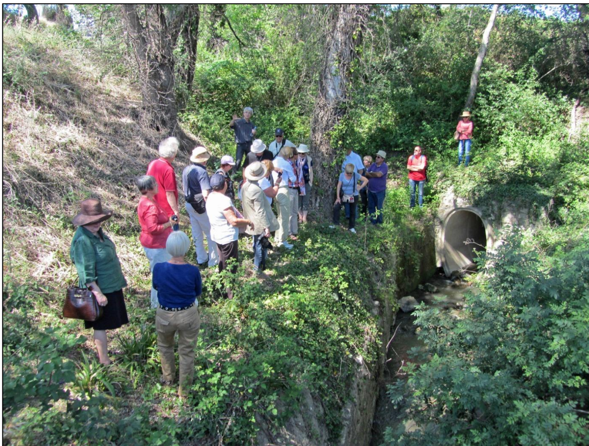
Le Malpas coté sud : la sortie du tunnel d'évacuation des eaux du périmètre (tunnel creusé au XIIIème siècle)
